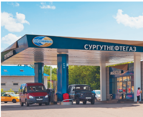
АЗС после реконструкции привлекает больше клиентов
